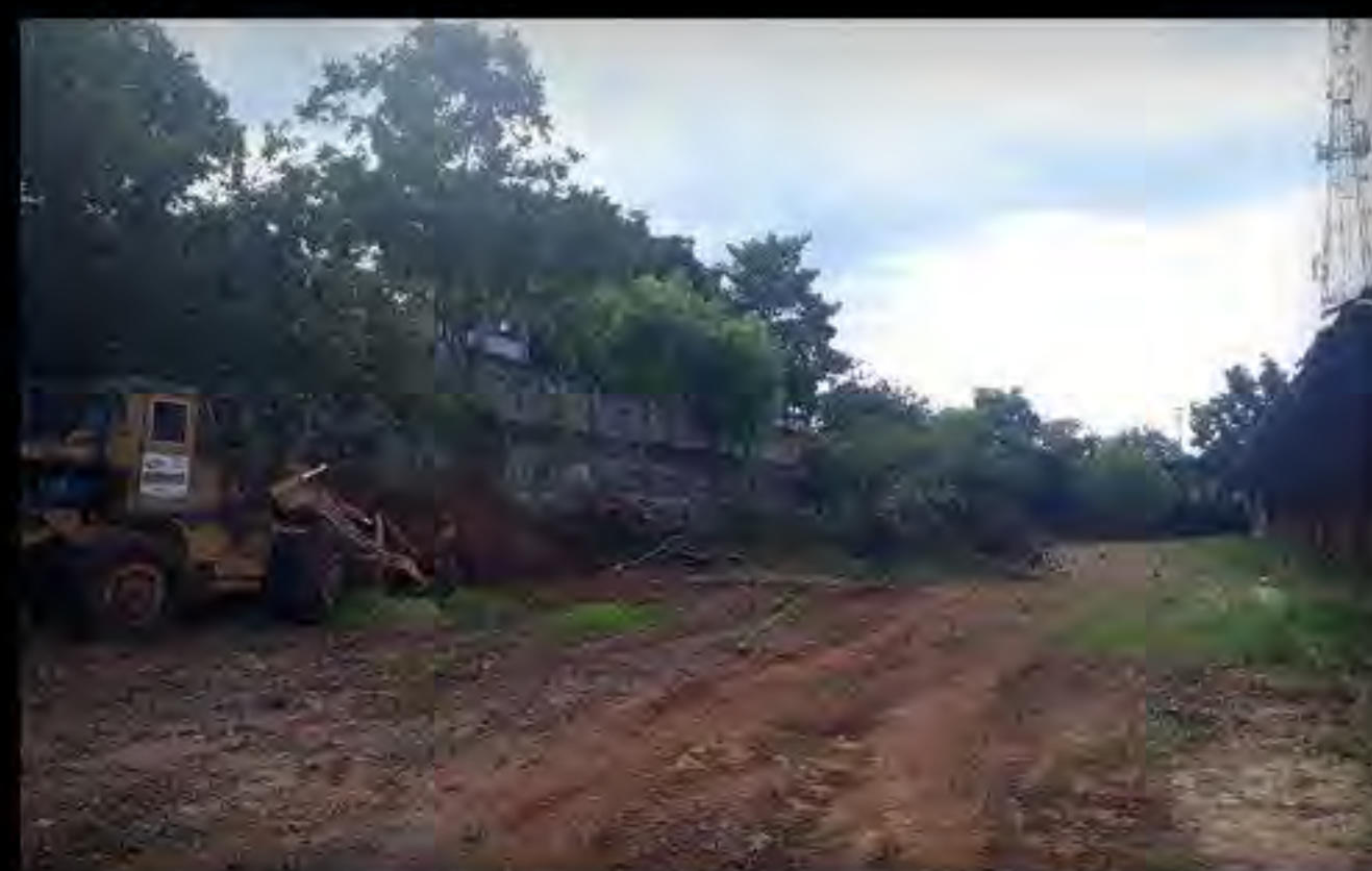
IMG. 45. ÁREA DO MURO DE ARRIMO ATRÁS DO ARMAZÉM
