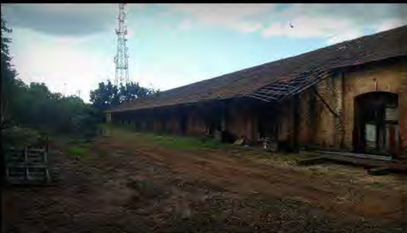
IMG. 23. FOTO DA LATERAL DO ARMAZÉM
